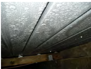
Kondensatbildung unter dem Pultdach
