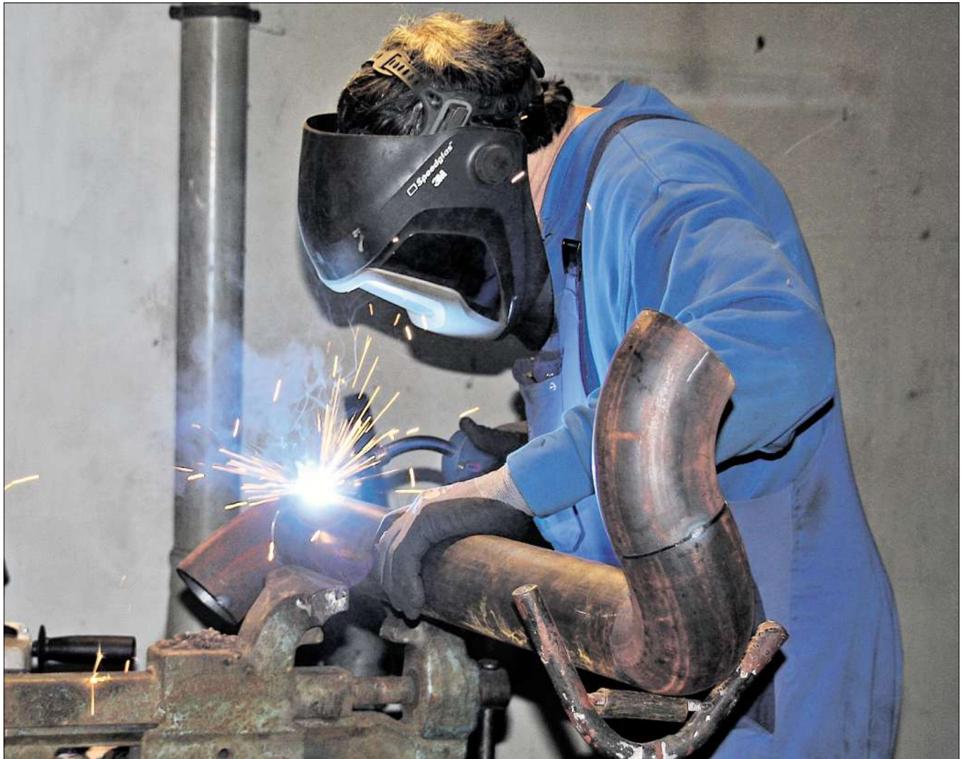
Die Teile werden vor Ort angepasst: Hubert Richter von der Firma AME schweißt die Rohre zusammen.
