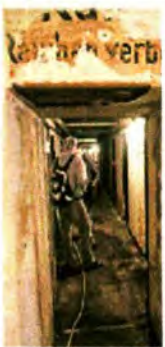
Ein sicherer Platz unter dem Klagesmarkt. Die Stadt will den Bunker aufgeben.
