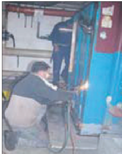
Funkenflug: Sven Kamutzki löst den Schwallwasserbehälter des großen Beckens heraus. Gallop
