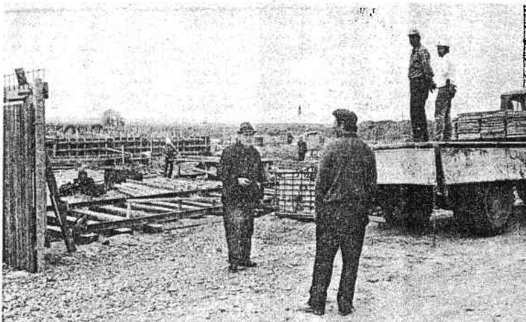
WOHIN DAS AUGESCHAUT — überall herrscht reges Leben auf der Großbaustelle in Pattensen.
