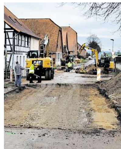
Die Bauarbeiter heben mitten in der Jeinser Ortsdurchfahrt eine tiefe Grube aus.
