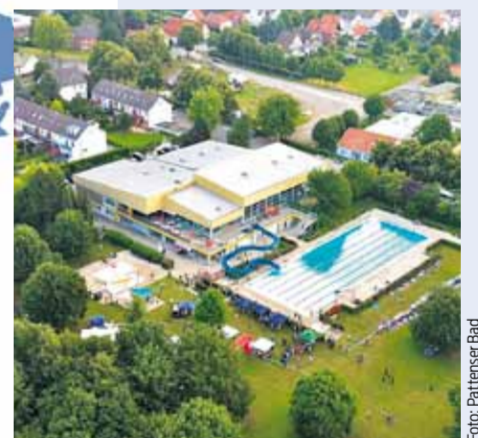
Foto: Pattenser Bad
